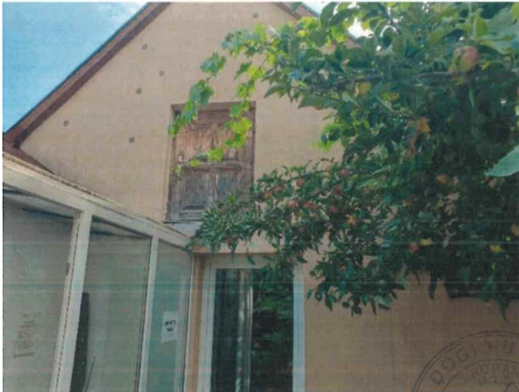
ACCES POD SI VEDERE SARPANTA
